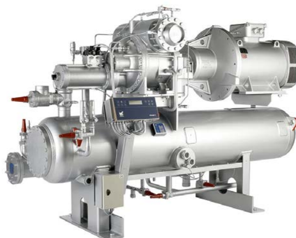
Слика 14.2 Чилер с вијчаним компресором
