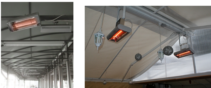
Слика 15.14 Грејање објеката зрачењем
