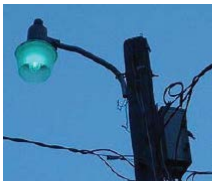
Слика 10.5 Живина сијалица високог притиска за спољну расвету
