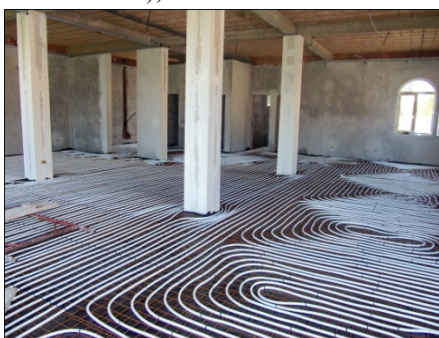
Слика 15.10 Цевуље за подно грејање пре постављања завршног слоја
