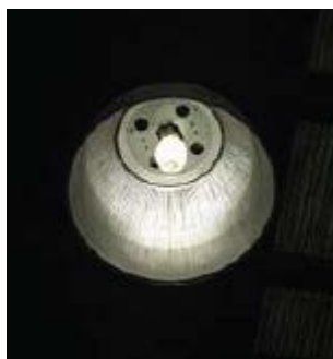
Слика 10.6 Метал-халогена сијалица за расвету фабричке хале
