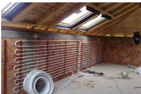
Слика 15.11 Постављање зидног грејања/хлађења
