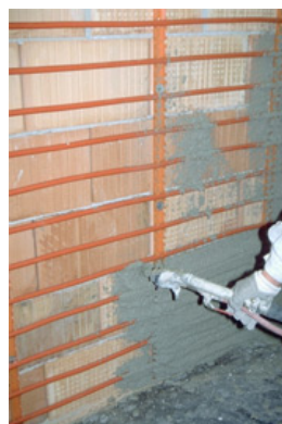
Слика 15.11 Постављање зидног грејања/хлађења
