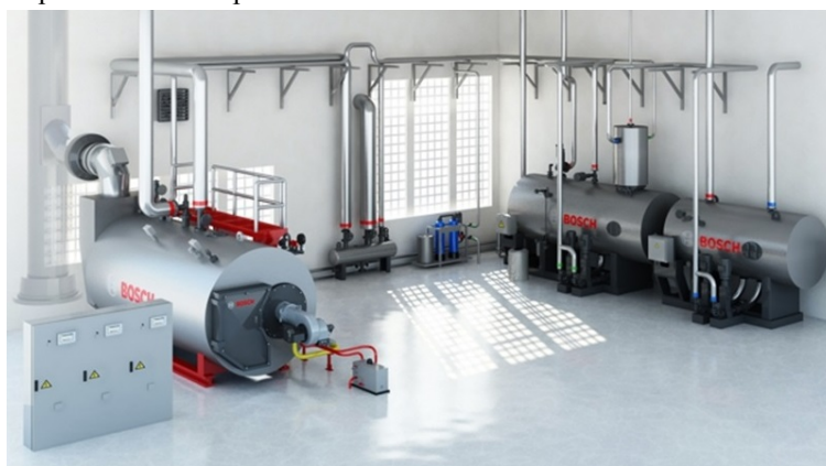
Слика 8.12 Типична парна котларница у индустрији [8.4]
